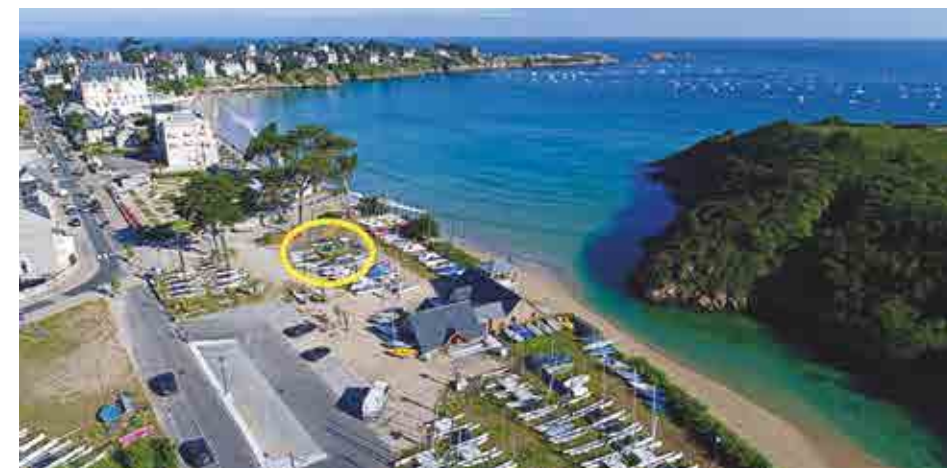
Emplacement de la future aire de rinçage (©Photo : Pierrick Contin)
