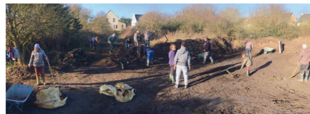
Chantier collectif de février : préparation du terrain pour la serre
